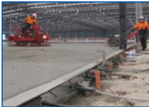
Beton döküm aşaması
